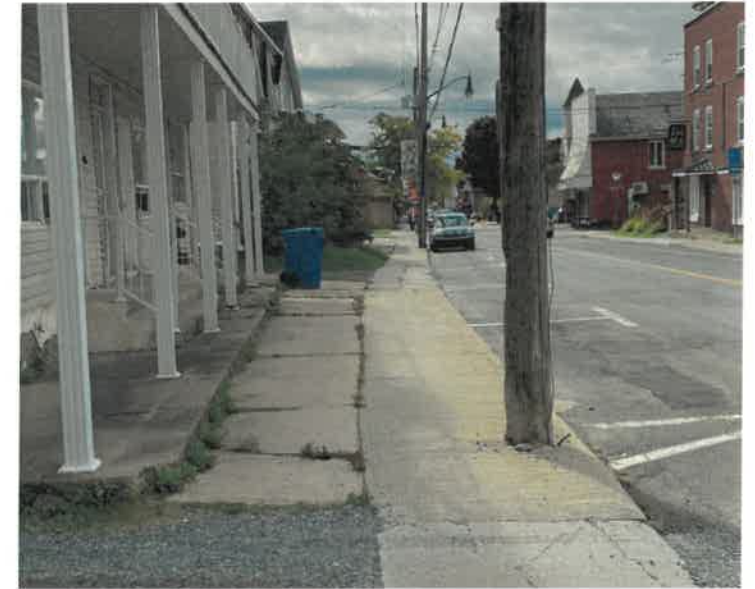
Aménagement des seuils sur la rue Principale N.
