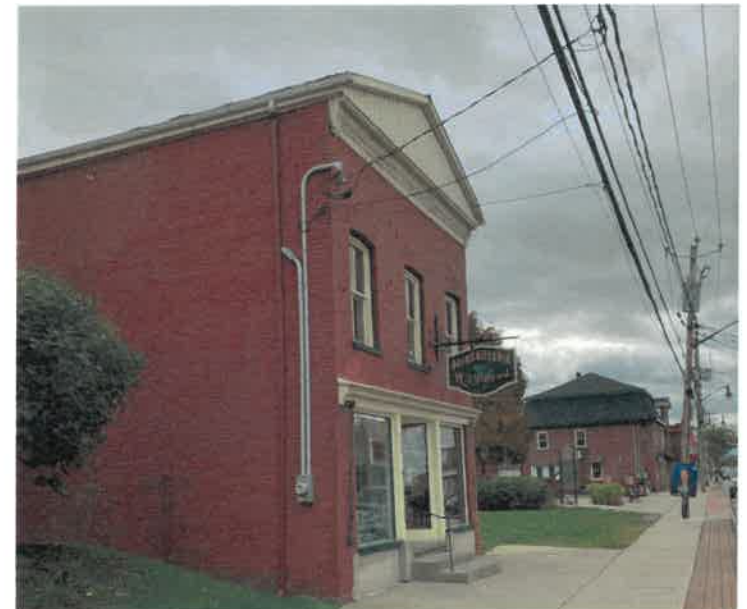
Immeuble mixte sur la rue Principale N.
