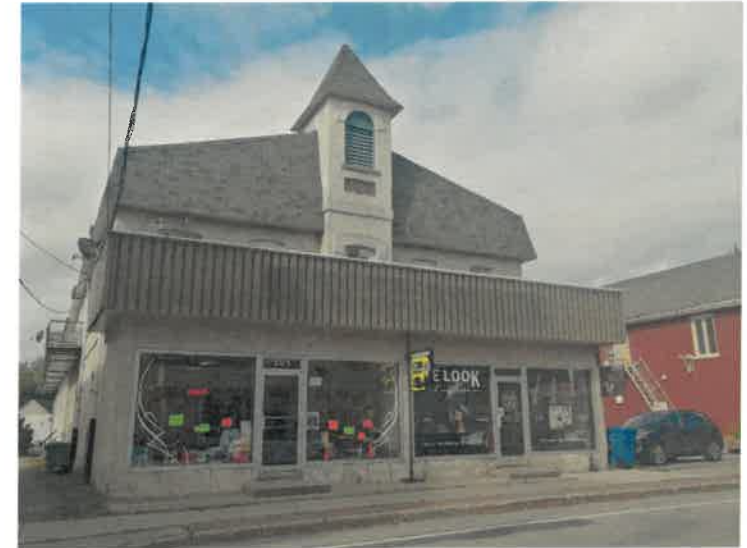
Immeuble mixte sur la rue Principale N.
